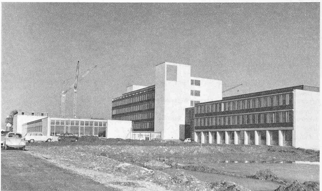
Bild 17. Südwestansicht Technische Physik und AFIF-Gebäude mit vorgelagertem Trakt Hilfsbetriebe («nichtstapelbare» Räume). Hinten Montagehalle
