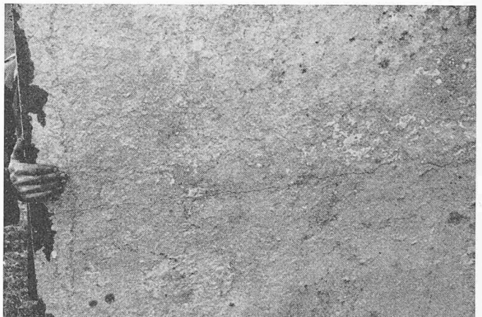
Platte 2 nach der Sprengung
