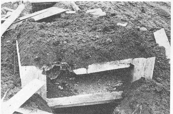
Platte 3 nach der Sprengung
