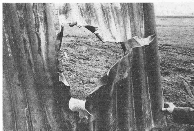
Platte 11 nach der Sprengung
