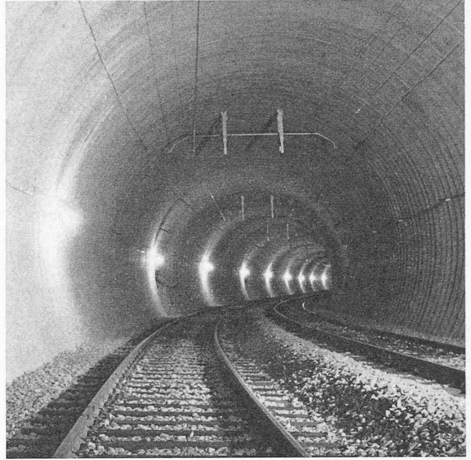
Bild 19. Beispiel Bern, fertiger Tunnel
