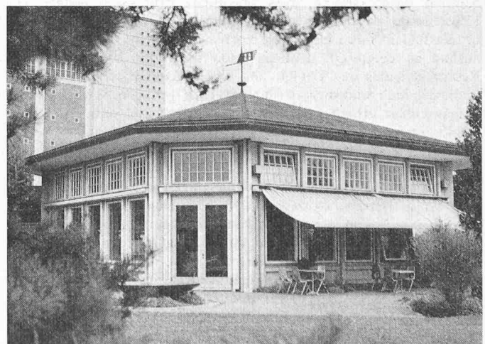
Die Kantine der EMPA-Neubauten. Im Hintergrund die Heizzentrale mit dem rechts angebauten Heisswasserspeicher
