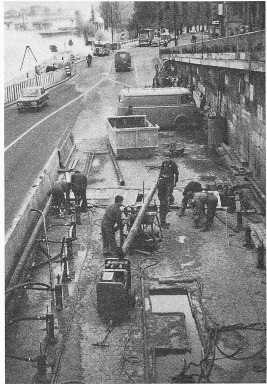
Figure 5. Aménagement de l'Hongrin-Léman, galerie d'adduction Est. Le jumbo rotatif et ses deux perforatrices, pour le forage et la mise en place des congélateurs (document S. I. F. — Photo Germond, Lausanne)
