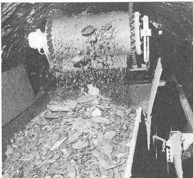
Bild 11. Übergabe des Haufwerkes vom Bandförderer in den Bunkerzug
