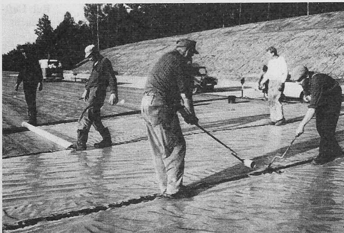
Bild 1. Schutz des Erdplanums mit Polyäthylen-Folien, die an den Rändern verklebt werden
