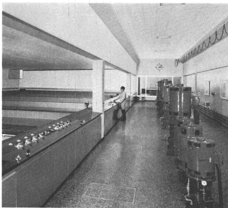
Schnellfilteranlage «Champ-Bougin» der Stadt Neuenburg für das Aufbereiten von Seewasser zu Trinkwasser. Leistung 1800 m 3 /h
