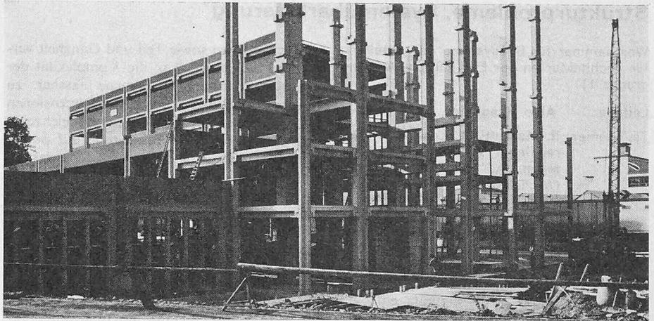
Bild 2 (l.). Konstruktives Gerippe, in welches beliebige Fassadenelemente eingebaut werden können
