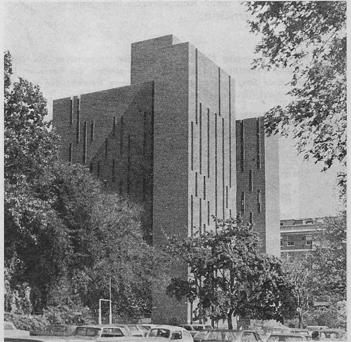
Bild 2. Zehnstöckiger Laboratoriumsturm der medizinischen Abteilung der Universität Yale (Architekten: Douglas Orr, de Cossy, Winder). Wie bei den andern Laboratoriumsbauten für Chemie und Physik (Architekt Philipp Johnson) in dieser Stadt, weist das Gebäude nur wenige senkrechte Fensterschlitze auf. Damit wird eine sehr willkommene, zusätzliche äussere Arbeits- und Stellwand gewonnen. Das Gebäude ist vollständig klimatisiert. Die Fensterfläche genügt bei normalem Wetter vollständig zur allgemeinen Raumbelichtung
