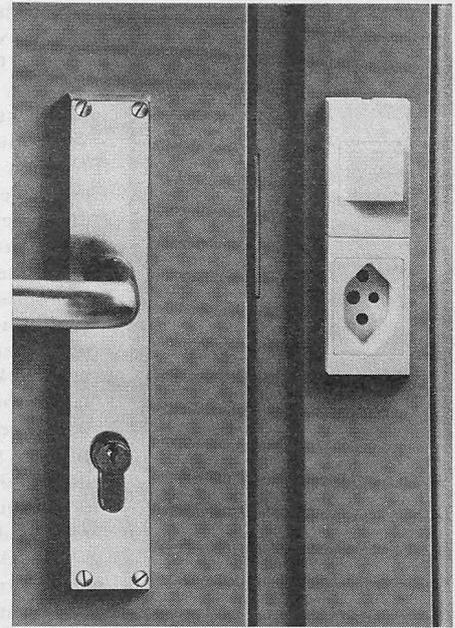
Bild 2. Druckschalter und Steckdose in der Türzarge
