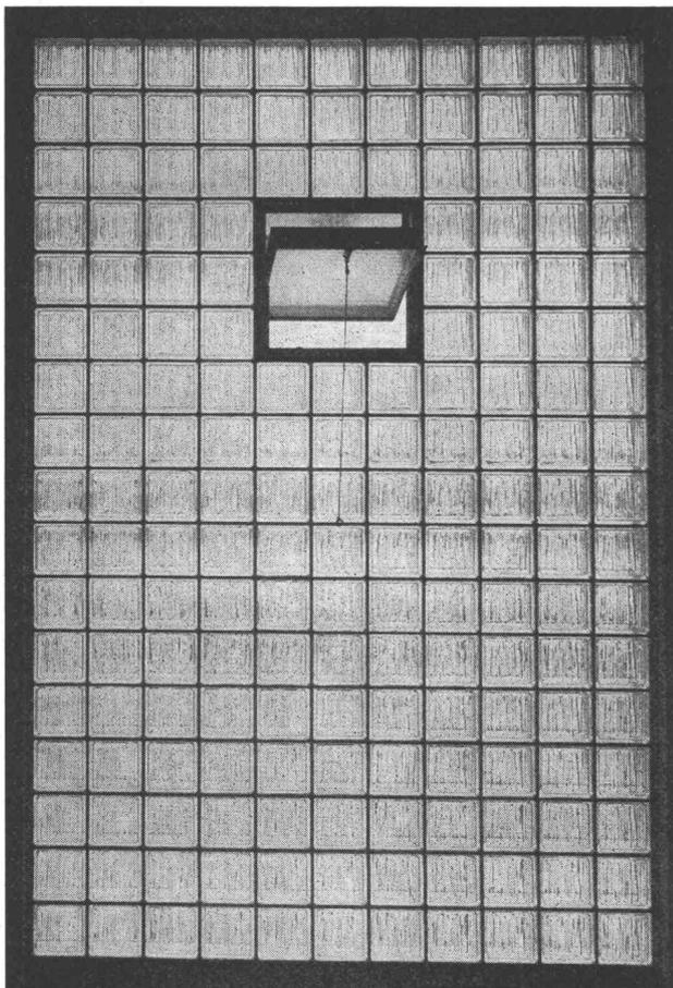
Dekorativer Glasbaustein Typ «Batonnets» in einer Treppenhauswand. Anticorodal-Schwingflügel, in beliebiger Höhe einbaubar (auch in anderem Mauerwerk) mit versetztem Drehpunkt und Zugvorrichtung zum Regulieren der gewünschten Oeffnung. Sichere Bedienung, auch in Höhen, die von Hand nicht mehr erreichbar sind. Lieferbar in diversen Grössen.
