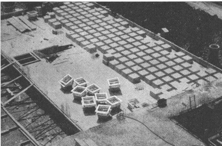
Vermietung von ausschalbaren Kunstharzschalungen für die Konstruktion von Kassettendecken mit gekreuzten Rippen, und von Relief-Verschalungselementen für Granit-Imitation von Betonmauern. Normierte Grössen. Spezialfabrikation auf Bestellung.
