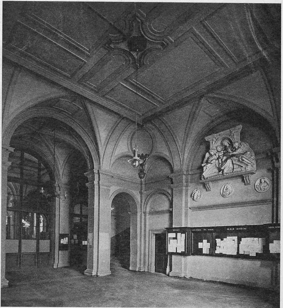
Bild 4. Halle des südlichen Eingangs zur Universität. Hier blieb Sempers Gestaltung im ursprünglichen Zustand (abgesehen von den nachträglich an den Wänden befestigten «Zutaten») erhalten
