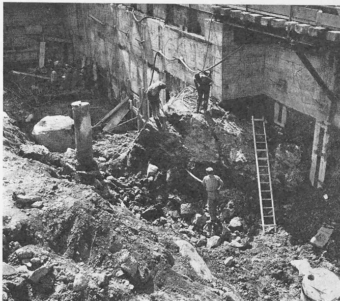
Blick in die Baugrube mit Findlingen bis zu rund 25 m 3 . Diese mussten hydraulisch gesprengt werden. Die noch verbleibenden Hindernisse zwangen zu einer Änderung der Baugrubensicherung durch Bohrpfähle mit Eisenbeton-Ausfachtung
