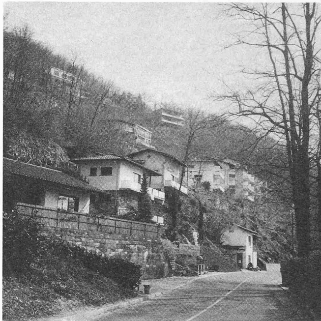
Häuser fressen sich in den «Bosco». Weitgehende Überbauung des vordem völlig bewaldeten Hanges. Dieser war durch die (wenn auch wirtschaftlich geringwertige) Niederwaldbestockung vor Erosion geschützt
