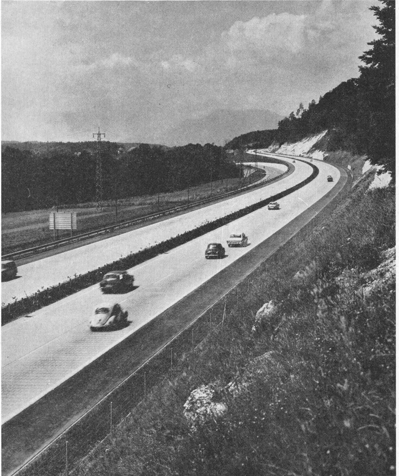
Nationalstrasse N1, Bern-Zürich im Kt. SO, Betonbelag
