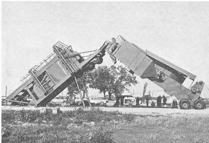
Bild 3. Die fertig aufgestellte Mischanlage «Batchpac» mit einer Leistung von 500 t/h. Das Fahrwerk und die Diagonalstreben müssen noch entfernt werden
