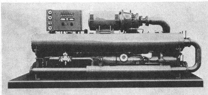
Ansicht der kompakten Kälteeinheit «Unitop» für Klimaanlage. Leistungen von 0,56 bis 1,2 Mio kcal/h (Werkphoto Sulzer)
