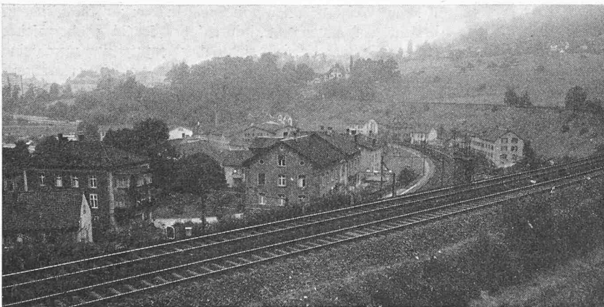
Bild 4. Tiefblick rheinabwärts auf den rechtsufrigen «Landeplatz» der Flurlingerbrücke. Das entscheidende Hindernis der Erstellung eines verkehrsgerechten Anschlusswerks sind die beiden um mehrere Meter gestaffelt übereinanderliegenden Bahnkörper der DB im Vordergrund und der SBB (dieser hier nur an Hand der Signale und Fahrleitungstragwerke erkennbar).
