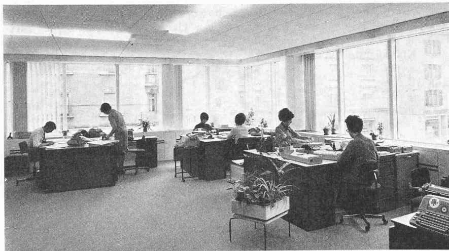
Vollklimatisierter Büroraum. Die Raumtemperatur lässt sich an Klimageräten in den Fensterbrüstungen individuell regulieren
