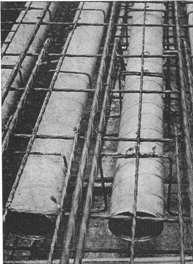
**Schalungsrohre** für den Betonbau
