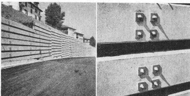
Verankerung von Beton-Elementen in Bohrpfehlen mit Felsanker AREFIX.
