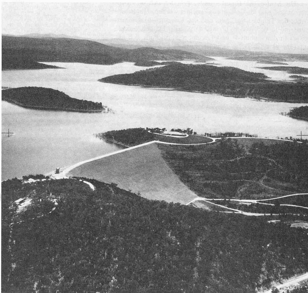
Bild 3. Der Eucumbene-Damm mit dem Hauptspeicher. Der 115 m hohe Stein- und Erddamm bildet ein Staubecken mit einer Wasserreserve von 4,7 Gm 3
