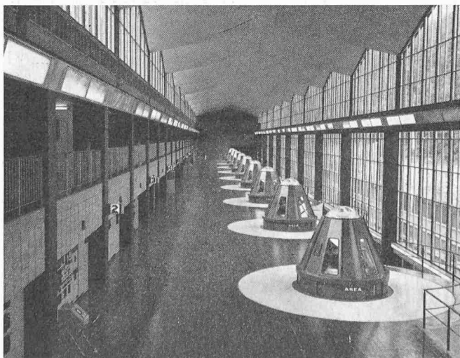
Bild 12. Blick in die Maschinenanlage des Kraftwerkes Murray 1 mit zehn 95-MW-Turbosätzen mit Francis-Turbinen
