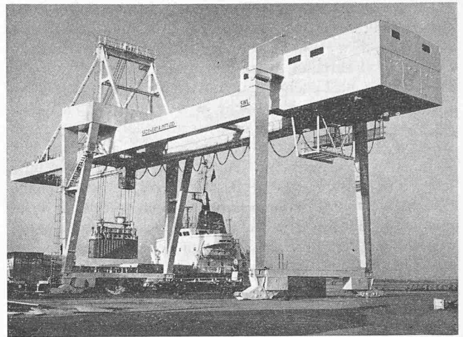
Bild 1. Ansicht des 30-t-Container-Umschlagkranes im Hafen von Harwich
