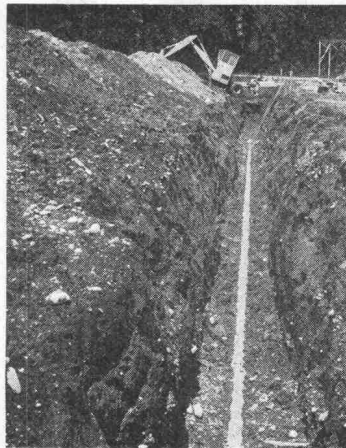
Graben für eine Rohrleitung
