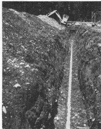
Graben für eine Rohrleitung
