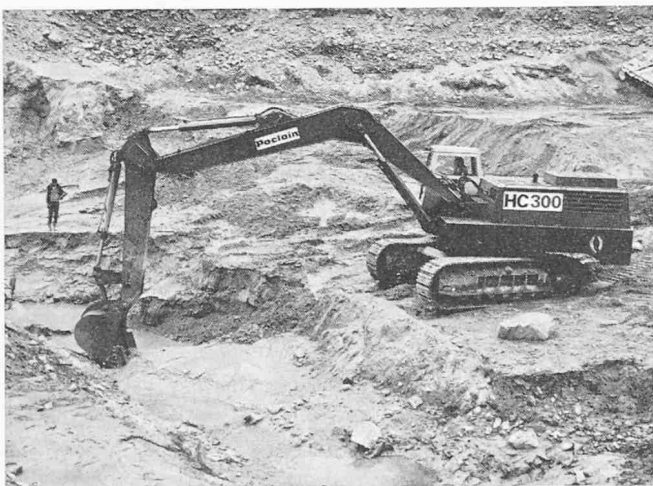
Bild 1. Der Hydraulikbagger Poclair HC 300 im Einsatz
