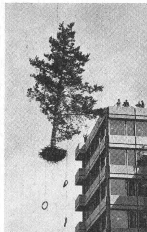
Versetzen von Bäumen
