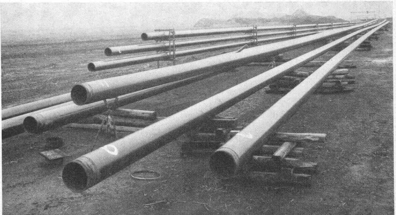
Das Foto zeigt zusammengeschweisste Rohrstränge aus kunststoffumhüllten Rohren für die Verlegung eines 3fach-Dükers.
