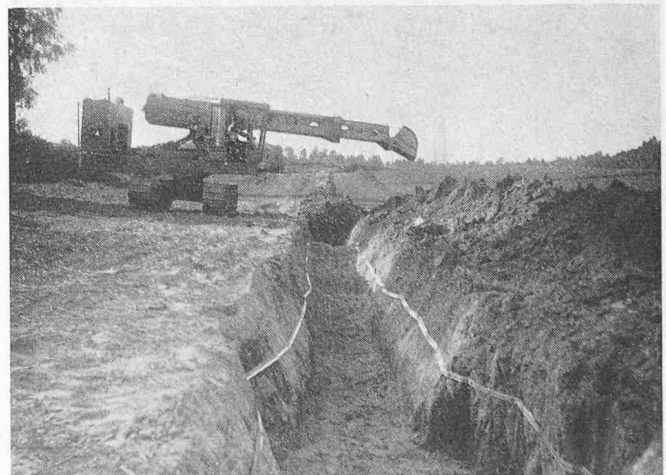
Bild 31. Eindecken des Grabens mit einem Gradall-Bagger. An den Grabenwänden sind in rund 50 cm Tiefe die Warnbänder angebracht
