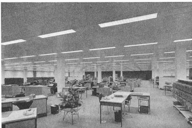
Bild 12. Grossraumbüros mit «Unipro»-Montagedecke in Einlegemontage. Die Luft wird durch Schlitzdiffusoren eingeblasen und durch die Leuchten abgesaugt
