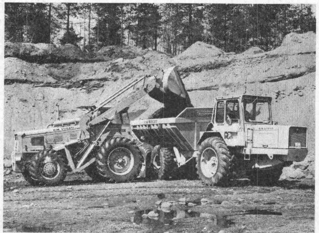
Er belädt Kipper und Mulden. Und sorgt mit seinen 85 Einsatzgeräten und einer Schnellkupplung für minutschnellen Gerätewechsel, dass er nie still steht!
