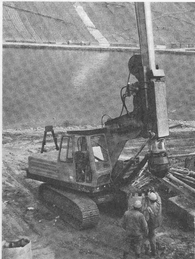
Bild 1. JCB-Bagger Typ 7 C mit angebauter Tiefschachteinrichtung
