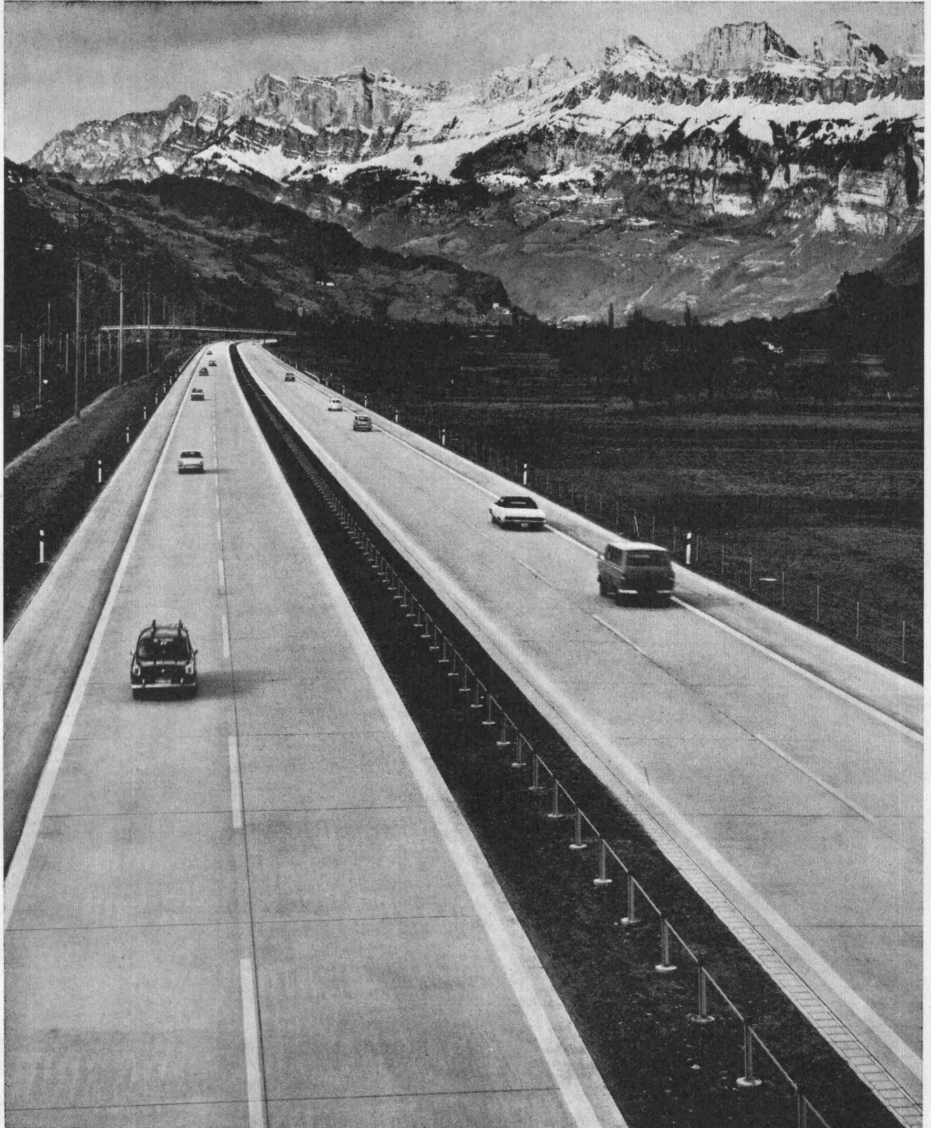
Nationalstrasse N 3 Zürich—Chur, Teilstrecke Flums—Mels, Betonbelag
