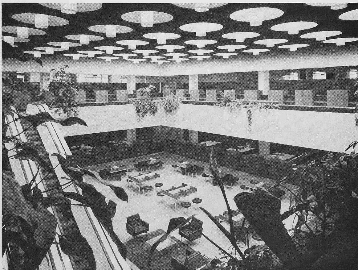
Schalterhalle Erdgeschoss/1. Obergeschoss
