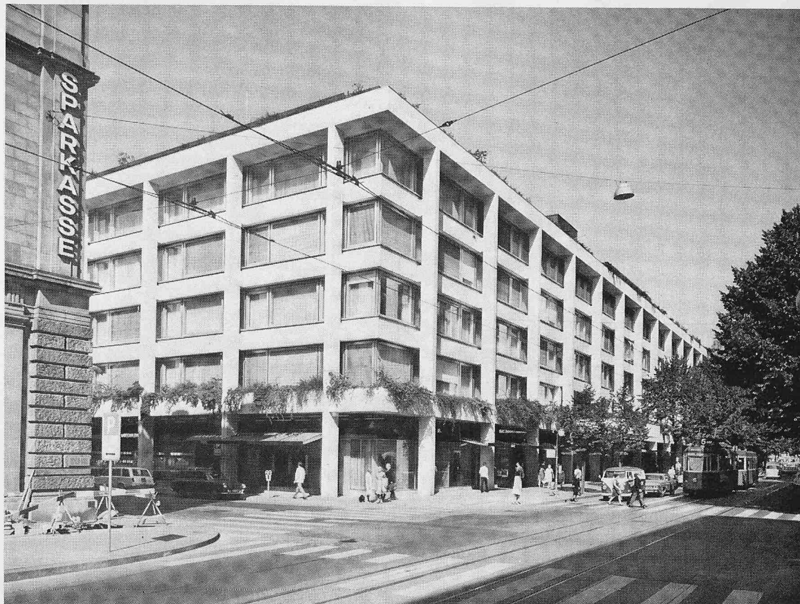
Fassaden Ecke Bahnhofstrasse/Börsenstrasse
