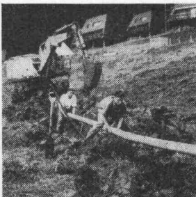
Kanalisation Schwyz: Rothenturm
