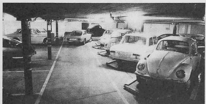
Bild 3. Einfahren auf eine Plattform. Sie ist von den Nachbarplattformen automatisch frei gestellt und im Winkel von 45° zum Fahrer hin gerichtet
