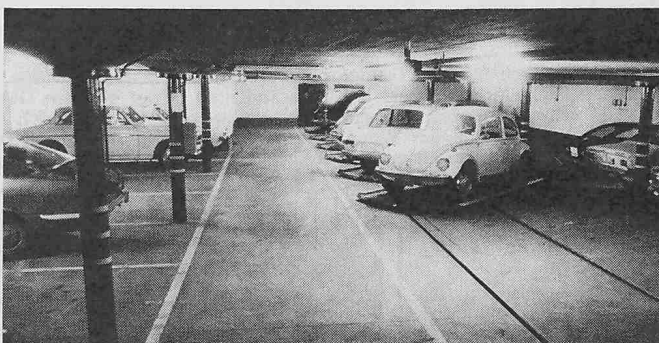
Bild 5. Nach erfolgtem Freigabebefehl haben sich die Plattformen selbsttätig in die Ausgangsstellung zusammengeschoben
