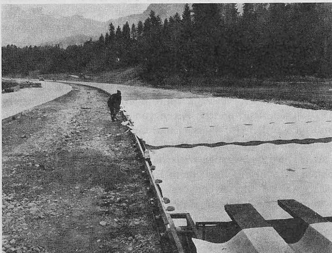
Wärmedämmung. Die Lieferfirma für die Schaumstoffolie war Airex S. A., Sins. Täglich wurden durchschnittlich 125 m<sup>2</sup> Strassendecke betoniert. Trotz Tagestemperaturen von 8 bis 12°C, fielen die Temperaturen in der Nacht auf -5 bis -8°C ab. Morgens wurde die Folie einfach aufgerollt und für den nächsten Abschnitt wieder verwendet.
