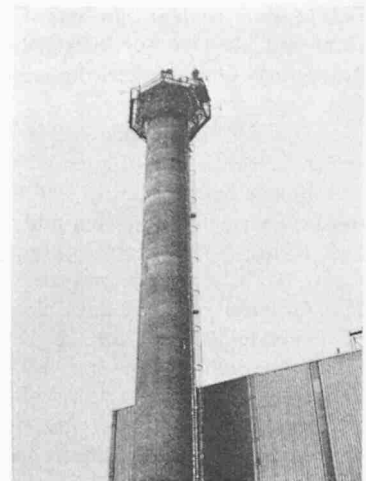
Bild 4. Das konische Hochkamin, 100 m hoch, für die Kehrlichtverbrennungsanlage in Colombier wurde in einem Monat hochgezogen
