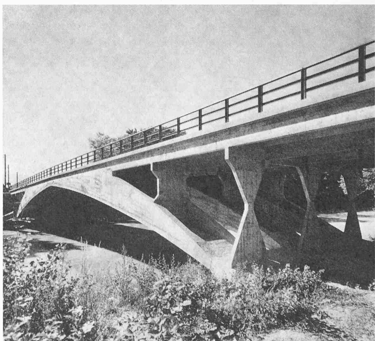
Arvebrücke bei Vessy (Genf), Spannweite 56 m. Erbaut 1936
