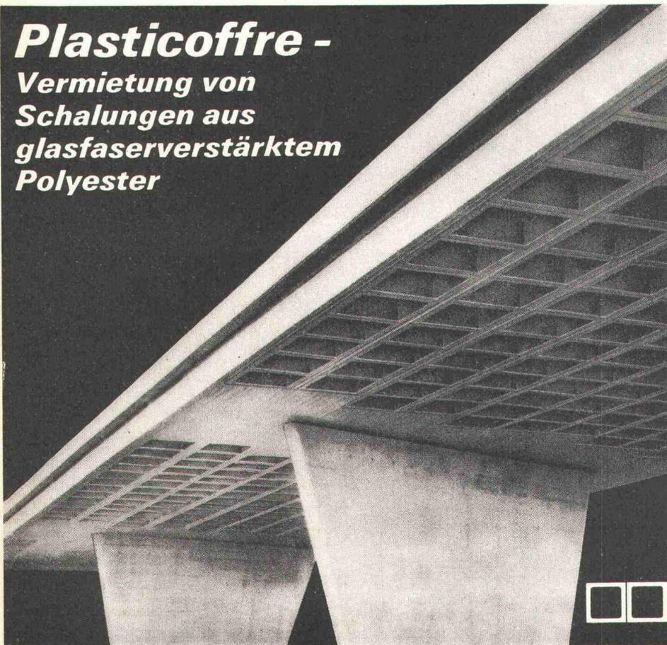
*Die zeitgemässe Lösung mit überzeugenden Vorteilen für den Bau von Kassettendecken aus Beton.*
