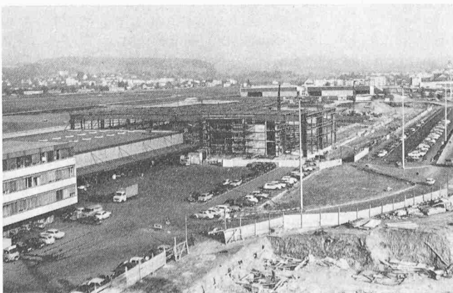
Ansicht des im Bau befindlichen Frachthofs Ost
