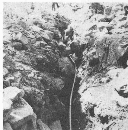
Bild 3. Auch bei grossen Blöcken und felsiger Grabensohle können die Weichpolyäthylenrohre verwendet werden. Alp von Gspon
