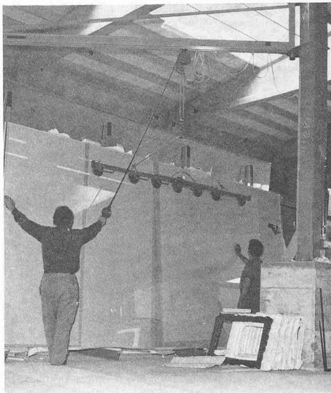
Bild 3. Handhabung grosser Glastafeln mit Kran und Sauger
