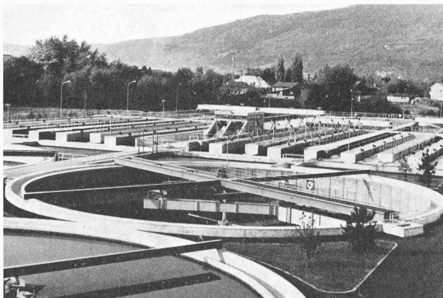
Bild 1. Kläranlage «Müra», Biel
