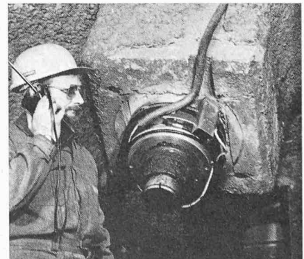
Bild 6, rechts. Einstellen des Kolbenhubes nach der Montage der Dose. Verständigung zwischen Kaverne und Messraum über Sprechfunk
