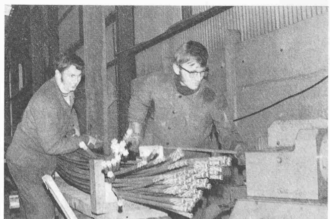
Bild 12. Aufstauchen von BBRV-Köpfen auf Litzen mittels Spezial-Stauchmaschine
