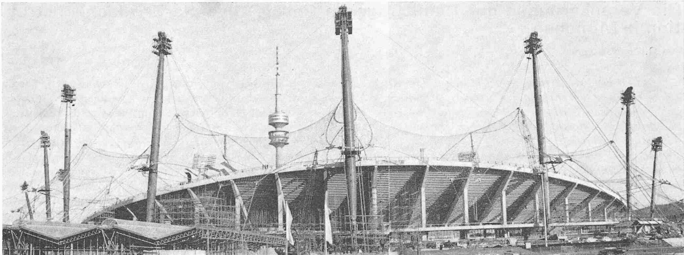
Bild 3. Seilnetzkonstruktion über dem Hauptstadion bei der Aufrichte im November 1971. Alle von den Pylonen ausgehenden Seile sind Haupttragseile
