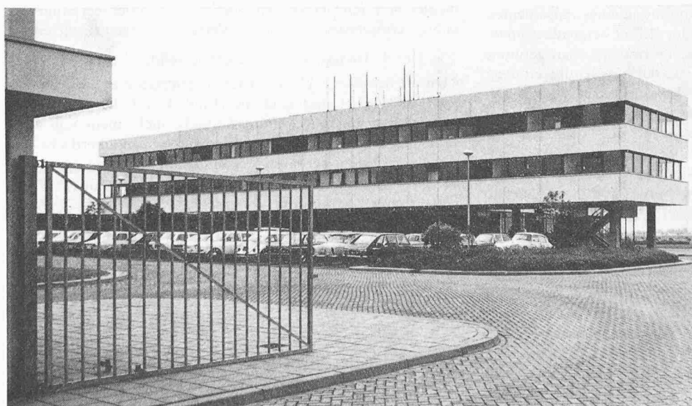
In diesem Gebäudeteil der Flugsicherungszentrale auf dem Flughafen von Maastricht werden die Mitarbeiter von Eurocontrol ihre Arbeit aufnehmen, wenn das Madap-System in die nationalen Flugsicherungssysteme integriert sein wird
