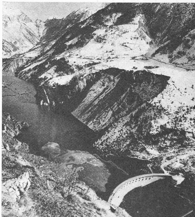
Bild 6. Erste grössere Felsrutschung von rund 700 000 m 3 in der Nähe der Sperrstelle auf der linken Talseite, oberwasserseitig
