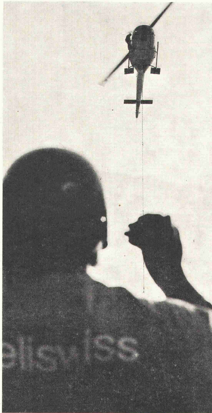
Einweisen einer Einzellast auf die Baustelle
