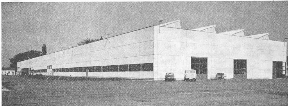
Bild 5. Ansicht der Halle von Südosten
